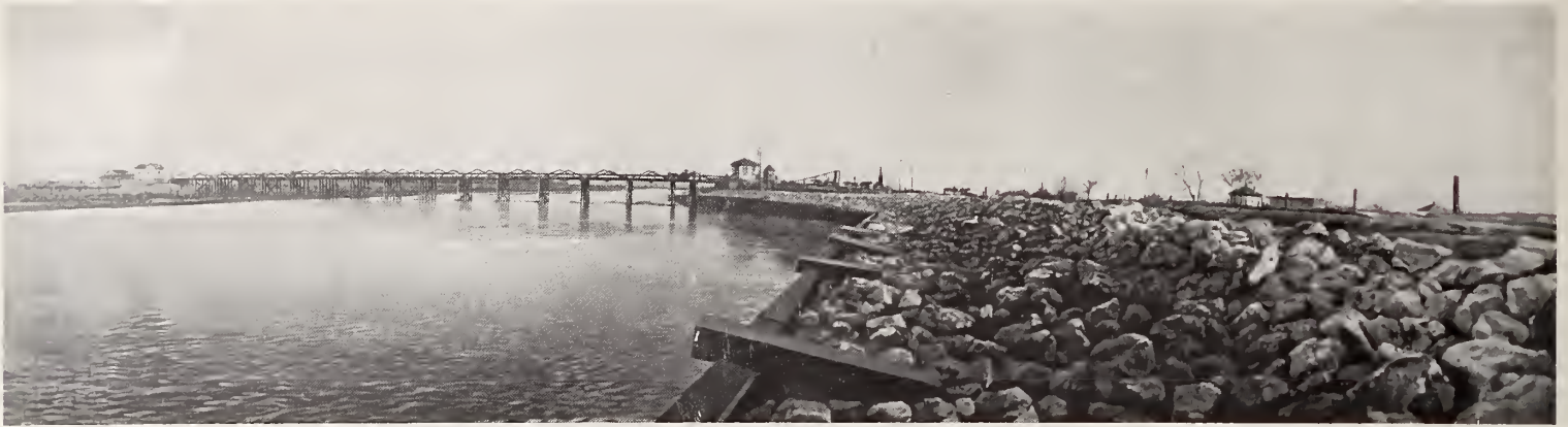
37. — PUENTE DE STANTON
